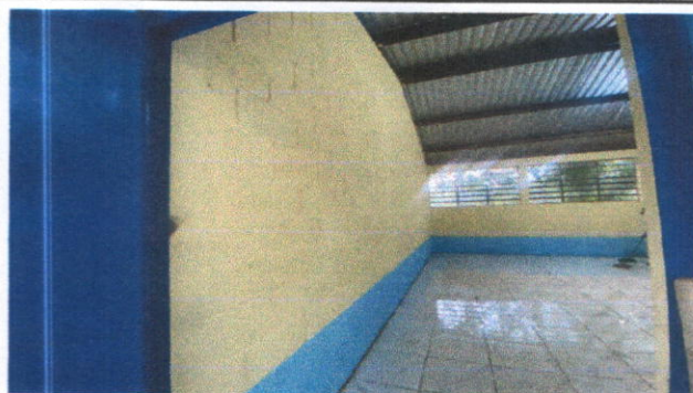
muros exteriores e interiores
