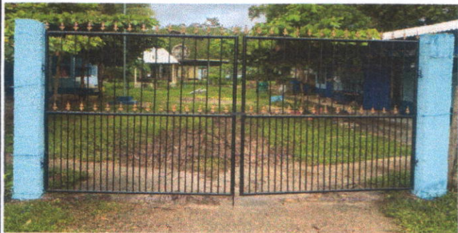
Sustitución de portón de metal
