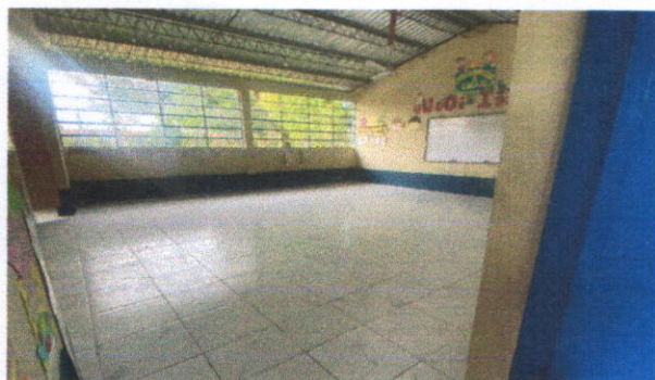
Sustitución de piso cerámico
