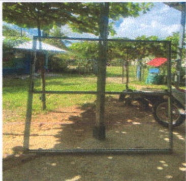
Sustitución de portón de metal
