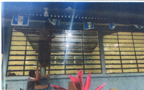
Mantenimiento ventanas de metal
