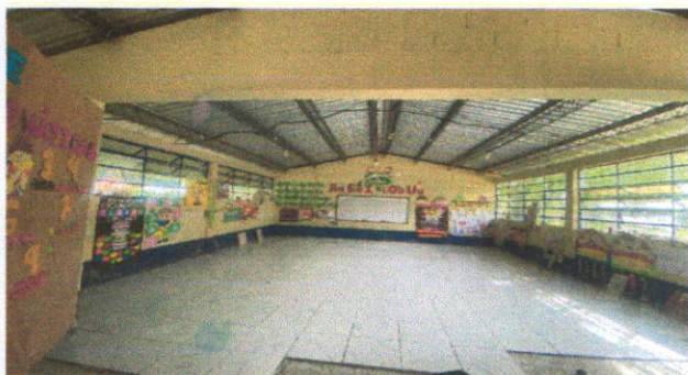
Sustitución de piso cerámico
