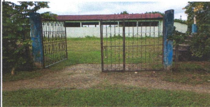
Sustitución de portón de metal
