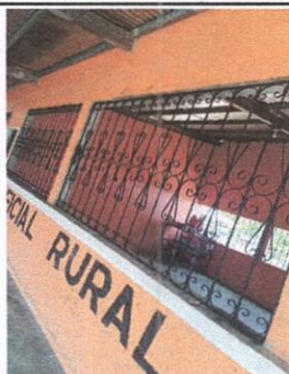
Foto 5: Mantenimiento a estructura de metal de ventana
