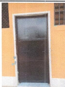
Foto 6: Mantenimiento a estructura (puertas)
