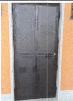
Foto 3: Sustitución de puerta
