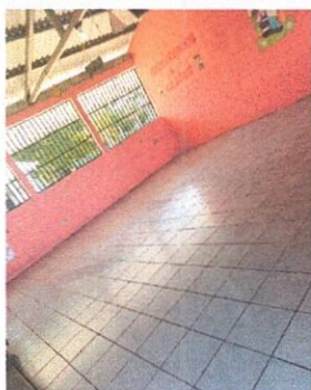
Foto 1: Mejoramiento de piso
