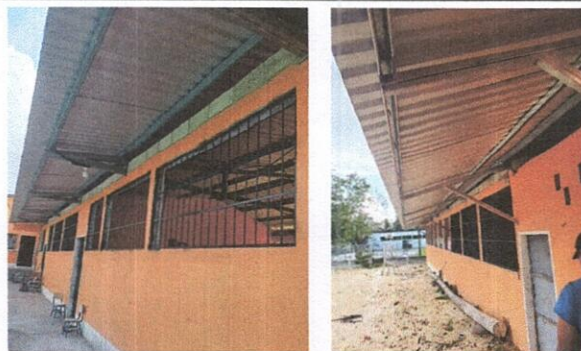
Foto 2: Fabricación e instalación de balcones de hierro en ventana, sustitución de lamina troquelada y sustitución estructura de soporte de madera por metal
