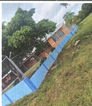
Foto 4: Pintura en muros exteriores e interiores
