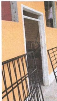
Foto 3: Sustitución de puerta
