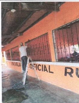
Foto 5: Mantenimiento a estructura de metal de ventana
