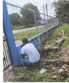
Foto 4: Pintura en muros exteriores e interiores
