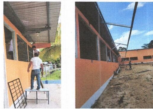
Foto 2: Fabricación e instalación de balcones de hierro en ventana, sustitución de lamina troquelada y sustitución estructura de soporte de madera por metal
