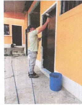
Foto 6: Mantenimiento a estructura (puertas)
