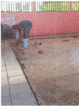
Foto 1: Mejoramiento de piso
