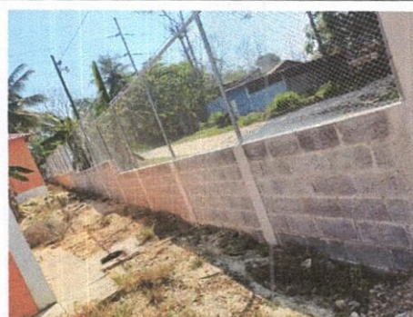
Foto 4: Pintura en muros exteriores e interiores
