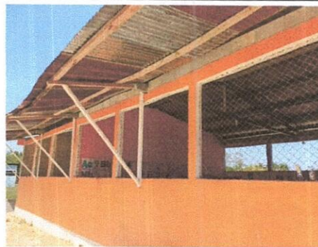
Foto 2: Fabricación e instalación de balcones de hierro en ventana, sustitución de lamina troquelada y sustitución estructura de soporte de madera por metal
