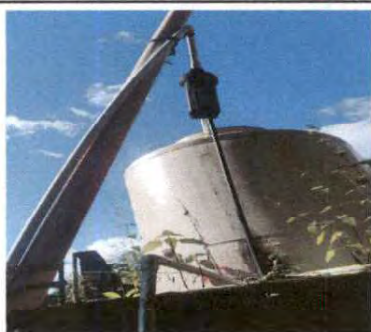
Foto 5: REPARACIÓN DE BAJADA DE AGUA PLUVIAL TUBO PVC 3"
