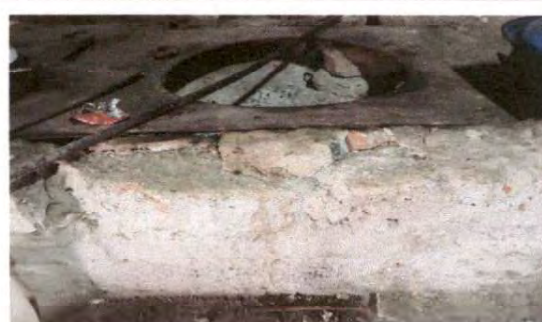
Foto 18: SUSTITUCIÓN DE ESTUFA RURAL (COMPLETA) INCLUYE CHIMENEA PLANCHA DE METAL
