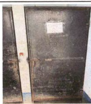
Foto 2: SUSTITUCIÓN DE PUERTA
