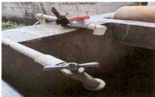
Foto 11: SUSTITUCIÓN DE LLAVE DE CHORRO
