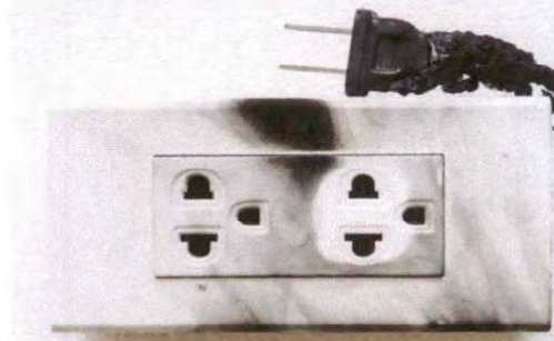
Foto 14: SUSTITUCIÓN DE TOMACORREINTES DOBLES
