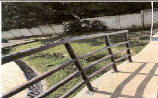
Foto 9: MANTENIMIENTO A BARANDAS DE METAL
