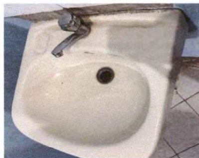
Foto 8: SUSTITUCIÓN DE LAVAMANOS
