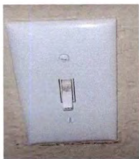
Foto 13: SUSTITUCIÓN DE INTERRUPTORES SIMPLES
