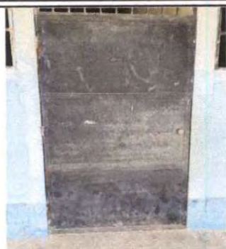
Foto 1: MANTENIMIENTO A ESTRUCTURA (LIJADO, CEPILLADO, SUJECCIONES, APLICACIÓN DE PINTURA)
