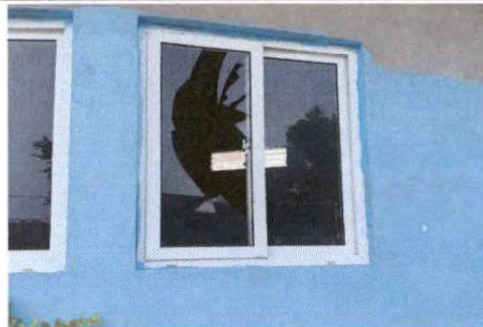
Foto 4: SUSTITUCIÓN DE VIDRIOS
