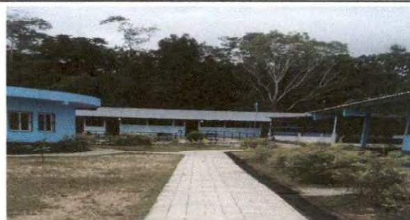
Foto 6: PINTURA EN MUROS EXTERIORES E INTERIORES
