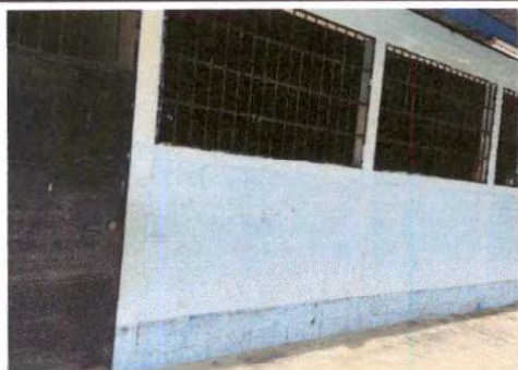
Foto 3: MANTENIMIENTO A BALCONES DE METAL
