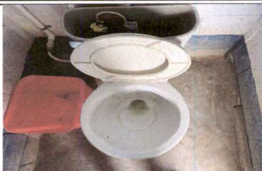
Foto 7: SUSTITUCIÓN DE INODOROS
