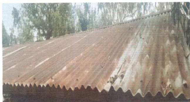
1.1 SUSTITUCION DE LAMINA TROQUELADA ALUZINC CALIBRE 26
