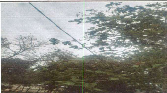
17.11 REPARACION DE CABLEADO ELECTRICO
