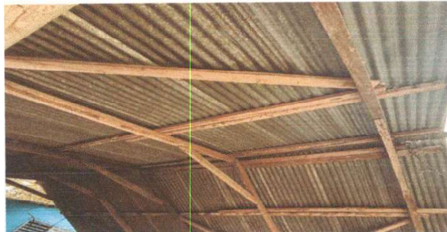
2.2 SUSTITUCION DE ESTRUCTURA DE SOPORTE DE MADERA , POR METAL
