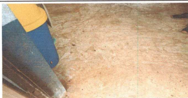
6.6 SUSTITUCION DE PISO DE CEMENTO LIQUIDO
