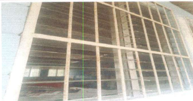
5.6 SUSTITUCION DE BALCONES DE METAL
