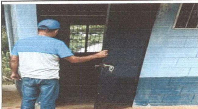
4.3 SUSTITUCION DE PUERTA
