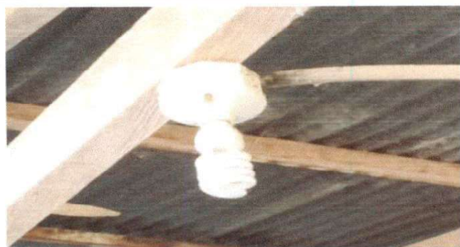
17.5 SUSTITUCION DE PLAFONERAS
