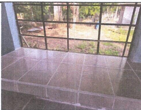
Foto 12: Instalacion de azulejo en estufa rural
