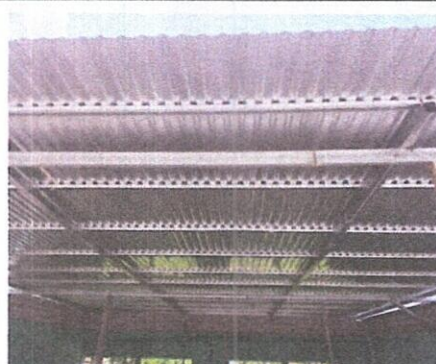
Foto 2: Sustitución de estructura de soporte
