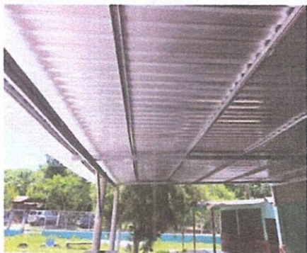
Foto1:Sustitución de lámina
