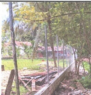
Foto 8: Reparacion de muro perimetral de block con tubo hg y malla galvanizada, soleras intermedias y columnas
