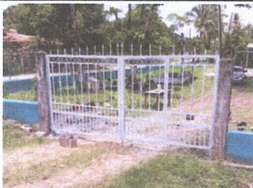
Foto 9: Fabricacion e instalacion de porton de metal de ingreso
