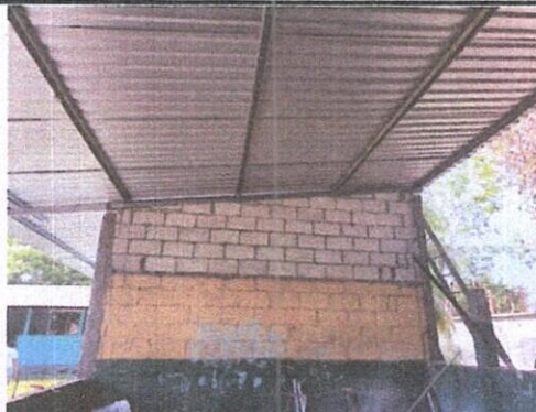
Foto 10: Instalacion de estructura portante de metal
