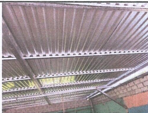
Foto 11: Instalacion de lamina troquelada aluzin
