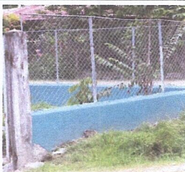
Foto 5: Pintura en muros exteriores e interiore
