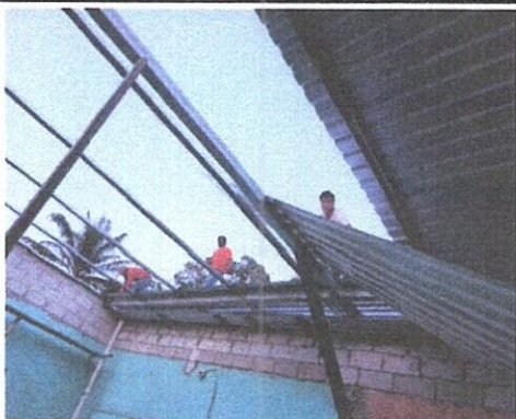
Foto1:Sustitución de lámina
