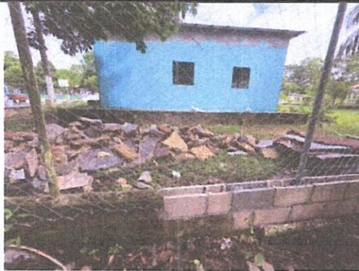
Foto 8: Reparacion de muro perimetral de block con tubo hg y malla galvanizada, soleras intermedias y columnas
