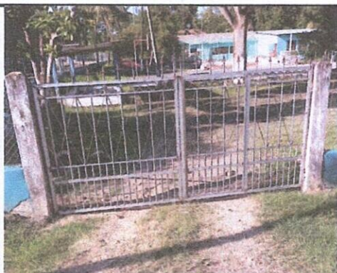
Foto 9: Fabricacion e instalacion de porton de metal de ingreso
