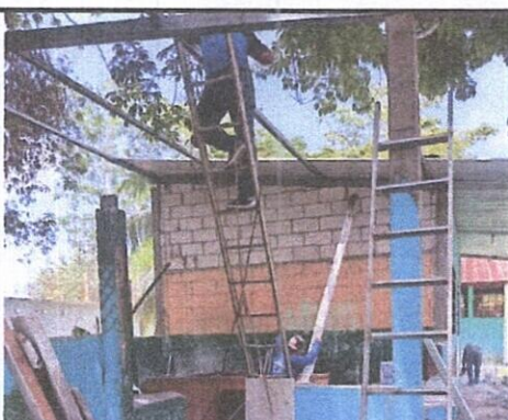
Foto 10: Instalacion de estructura portante de metal
