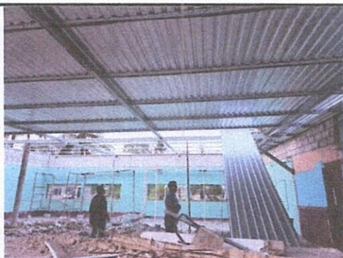
Foto 11: Instalacion de lamina troquelada aluzin
