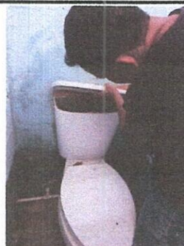
Foto 6: sustitucion de accesorios inodoro(contrallave,tubo de abasto y tanque
