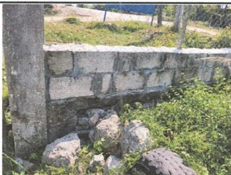
Foto 5: Pintura en muros exteriores e interiore
