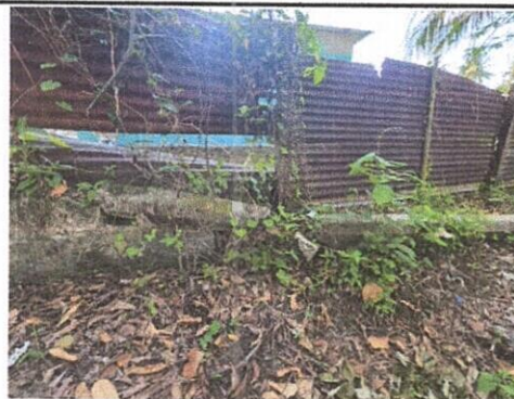
Foto 8: Reparacion de muro perimetral de block con tubo hg y malla galvanizada, soleras intermedias y columnas
