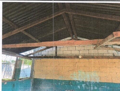
Foto 10: Instalacion de estructura portante de metal
