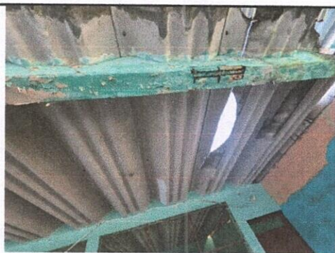
Foto 11: Instalacion de lamina troquelada aluzin
