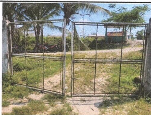
Foto 9: Fabricacion e instalacion de porton de metal de ingreso
