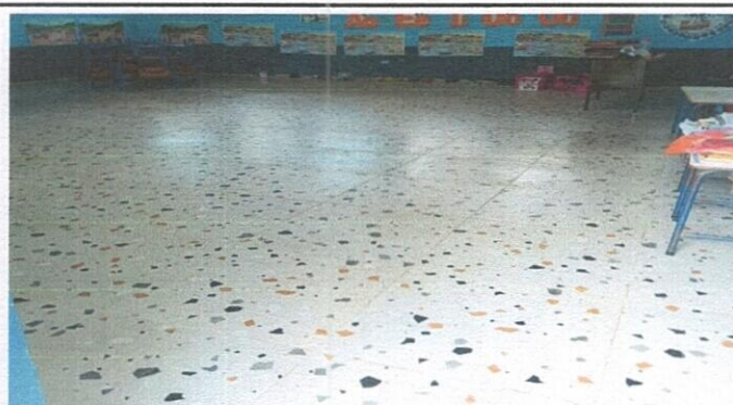
Foto 4: SUSTITUCION DE PISO LIQUIDO POR PISO CERAMICO
