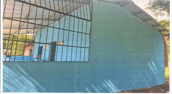
Foto 2: PINTURA EN MUROS INTERIORES Y EXTERIORES
