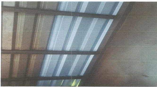
Foto 3: SUSTITUCIÓN DE LÁMINA, POR LÁMINA TROQUELADA
