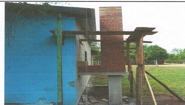
Foto 5: REPELLO EN MURO
