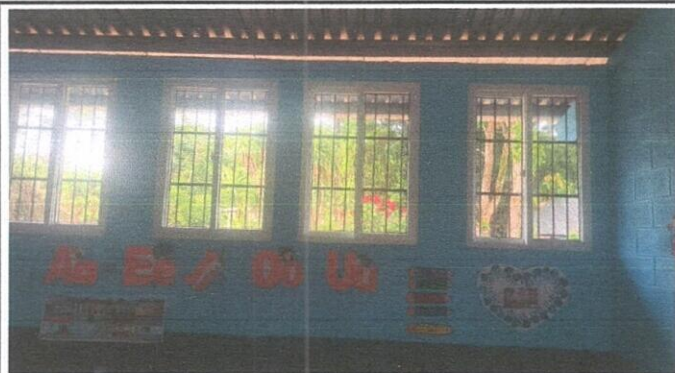
Foto 1: SUSTITUCION DE VIDRIOS POR VENTANAS PVC
