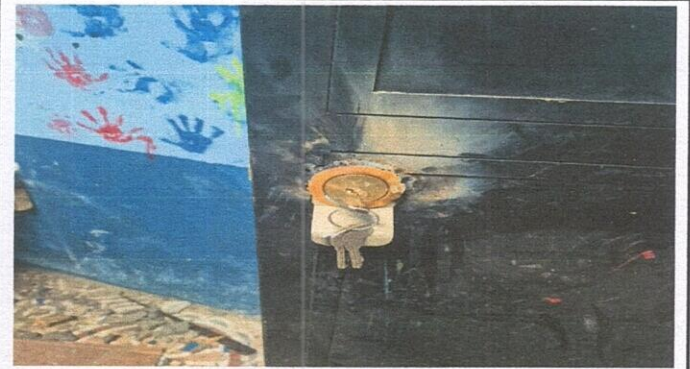
Foto 4: SUSTITUCIÓN DE CHAPA
