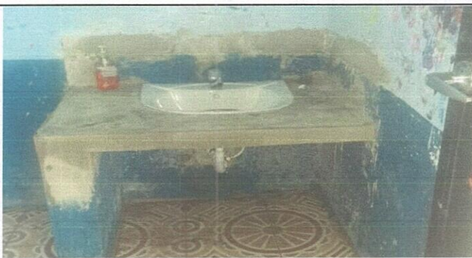
Foto 5: SUSTITUCION DE LAVAMANOS
