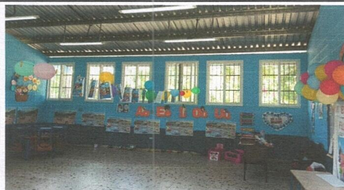
Foto 2: SUSTITUCION DE VIDRIOS POR VENTANAS PVC
