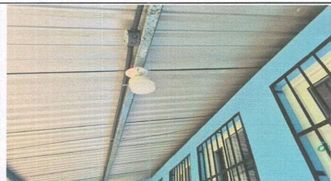
Foto 6 SUSTITUCION DE LAMPARAS LED
