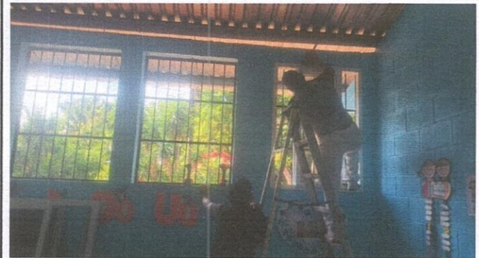
Foto 2: SUSTITUCION DE VIDRIOS POR VENTANAS PVC
