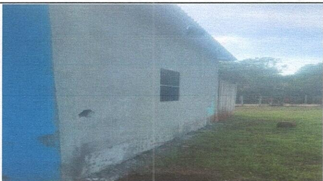
Foto 5: REPELLO EN MURO
