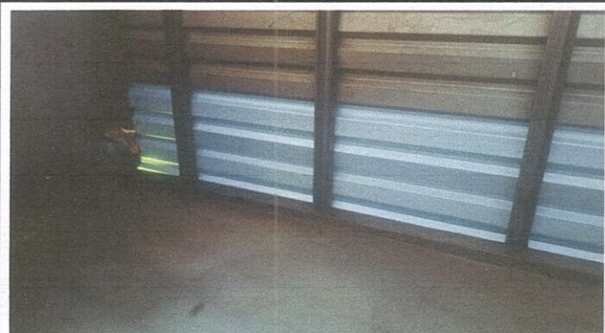
Foto 3: SUSTITUCIÓN DE LÁMINA, POR LÁMINA TROQUELADA
