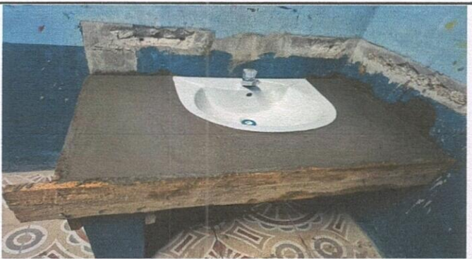
Foto 5: SUSTITUCION DE LAVAMANOS
