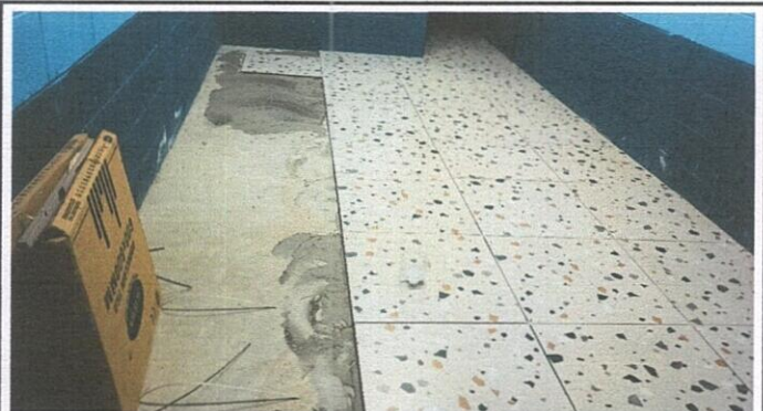
Foto 4: SUSTITUCION DE PISO LIQUIDO POR PISO CERAMICO
