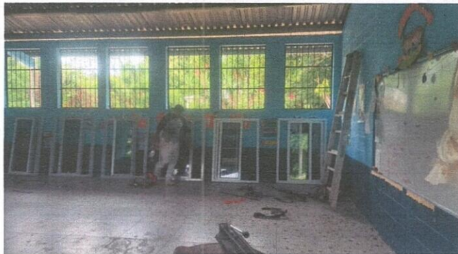
Foto 1: SUSTITUCION DE VIDRIOS POR VENTANAS PVC
