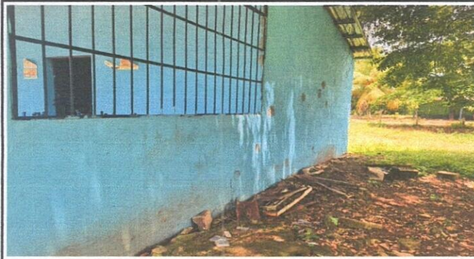
Foto 2: PINTURA EN MUROS INTERIORES Y EXTERIORES
