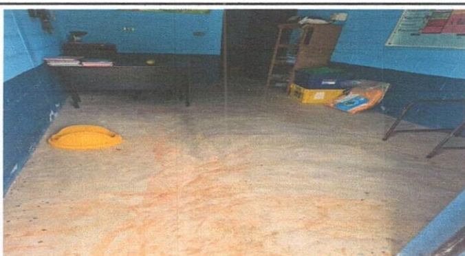
Foto 3: SUSTITUCION DE PISO LIQUIDO POR PISO CERAMICO
