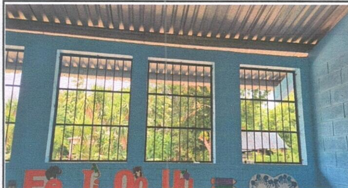
Foto 2: SUSTITUCION DE VIDRIOS POR VENTANAS PVC
