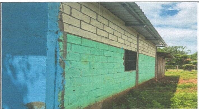
Foto 5: REPELLO EN MURO
