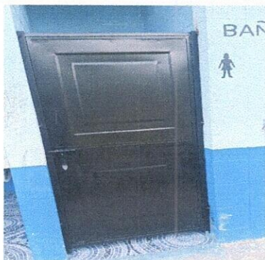
Foto 1: SUSTITUCION DE PUERTA EN SERVICIO SANITARIO
