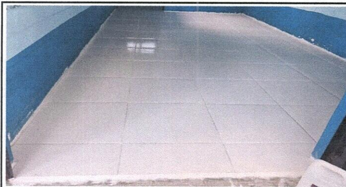
Foto 5: SUSTITUCION DE PISO LIQUIDO
