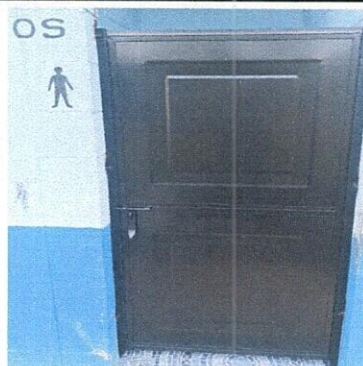
Foto 2: SUSTITUCION DE PUERTA EN SERVICIO SANITARIO
