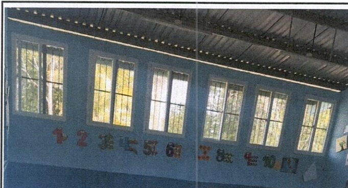
Foto 4: SUSTITUCION DE VIDRIOS EN VENTANAS
