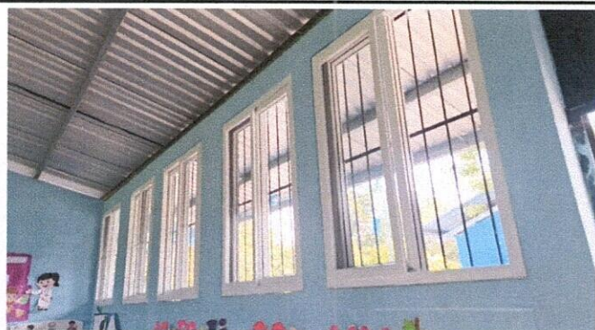
Foto 3: SUSTITUCION DE VIDRIOS EN VENTANAS
