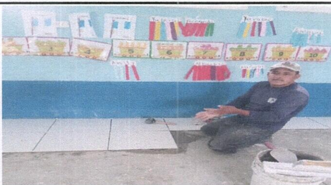
Foto 6 SUSTITUCION DE PISO LIQUIDO
