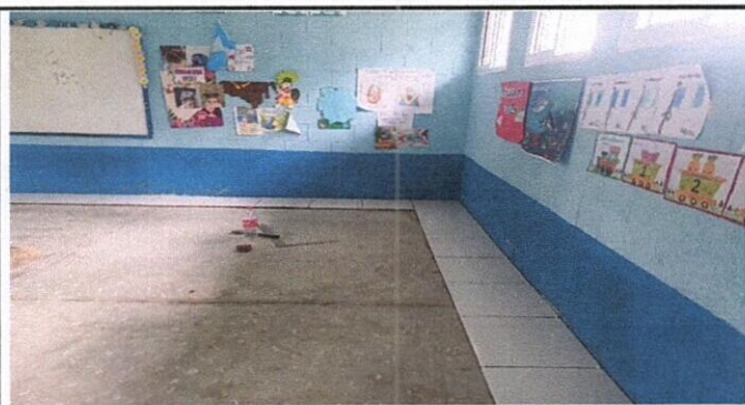
Foto 5: SUSTITUCION DE PISO LIQUIDO
