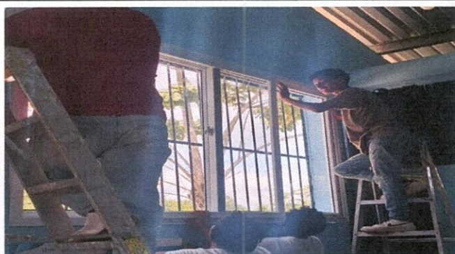
Foto 3: SUSTITUCION DE VIDRIOS EN VENTANAS
