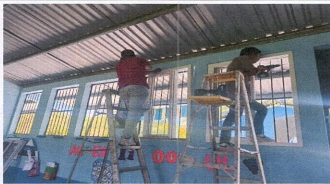
Foto 4: SUSTITUCION DE VIDRIOS EN VENTANAS
