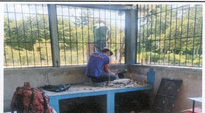
Foto 4: SUSTITUCION DE ESTUFA RURAL
