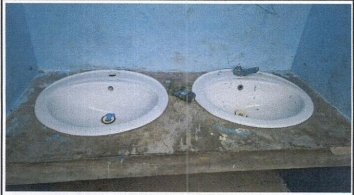
Foto 2: SUSTITUCION DE GRIFOS
