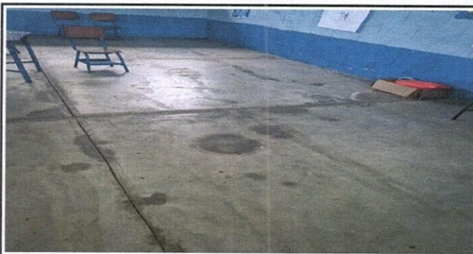
Foto 5: SUSTITUCION DE PISO LIQUIDO
