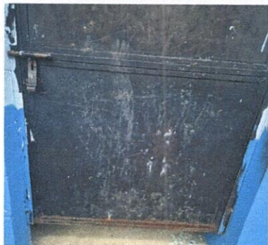
Foto 1: SUSTITUCION DE PUERTA EN SERVICIO SANITARIO
