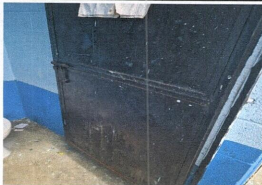
Foto 2: SUSTITUCION DE PUERTA EN SERVICIO SANITARIO
