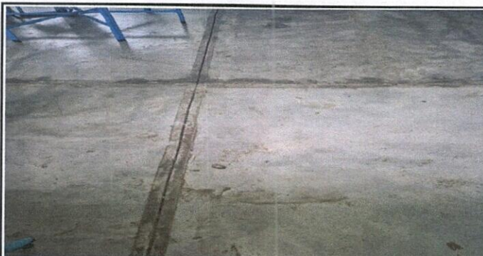
Foto 6: SUSTITUCION DE PISO LIQUIDO
