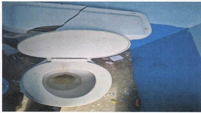
Foto 1: SUSTITUCION DE SANITARIO
