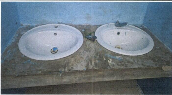
Foto 3: SUSTITUCION DE CEMENTO LIQUIDO POR AZULEJO
