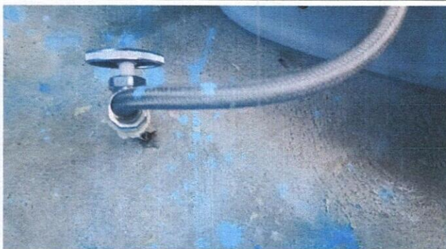
Foto 10: Sustitución de Contrallave
