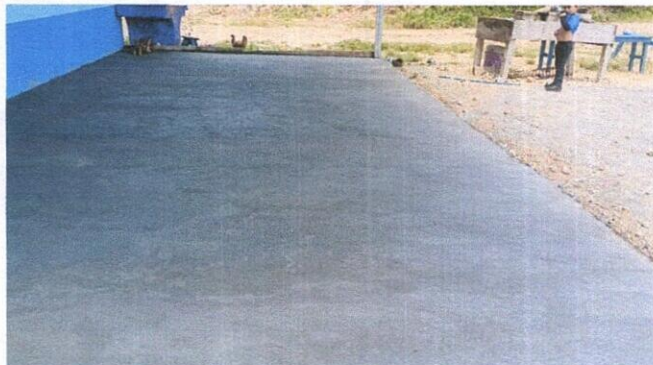
Foto 8: Instalación de Piso de Torta de Cemento
