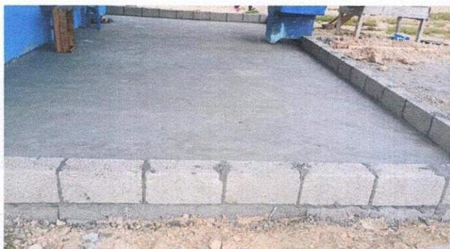
Foto 9: Instalación de Block
