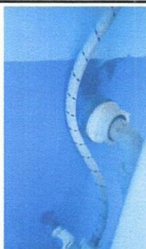
Foto 11: Sustitución de Manguera Flexible
