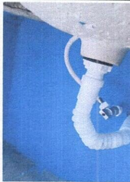
Foto 6: TUBERIA DE DRENAJE
