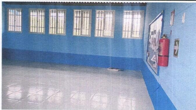
Foto 2: MEJORAMIENTO DE PISO
