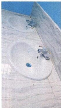
Foto 7: Mejoramiento de Azulejos en Lavamanos
