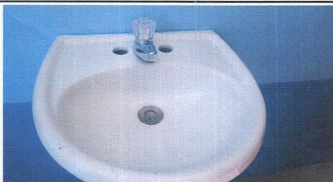
Foto 12: Sustitución de llave para lavamanos
