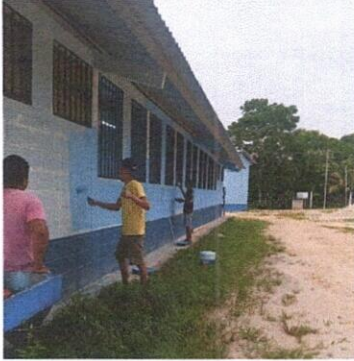
Foto 1: PINTURA EN MUROS
