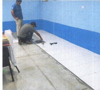
Foto 2: MEJORAMIENTO DE PISO
