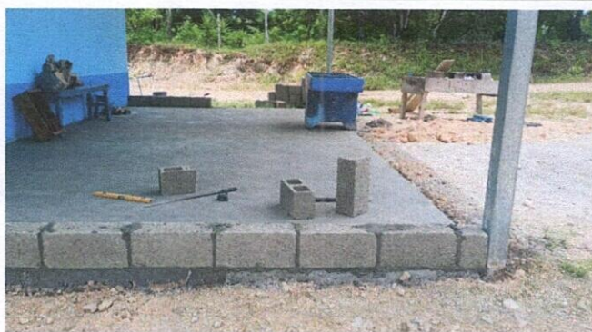
Foto 9 Instalación de Block
