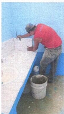
Foto 7: Mejoramiento de Azulejos en Lavamanos
