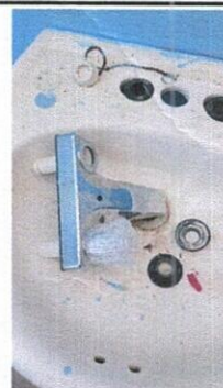
Foto: 12 Sustitución de llave para lavamanos
