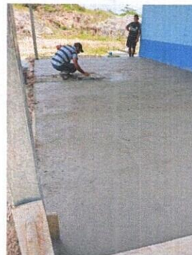
Foto 8: Instalación de Piso de Torta de Cemento
