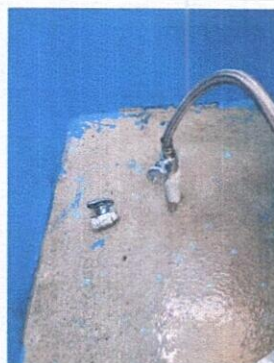
Foto: 10 Sustitución de Contrallave
