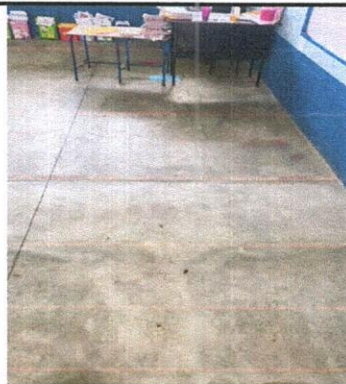
Foto 2: MEJORAMIENTO DE PISO
