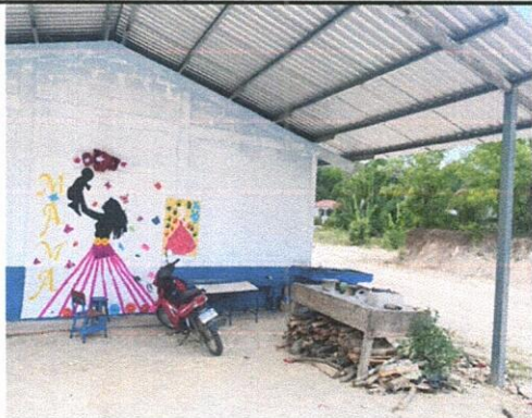
Foto 1: PINTURA EN MUROS
