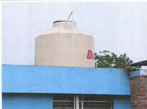
Foto 3: Sustitución de deposito de agua 1750 lt
