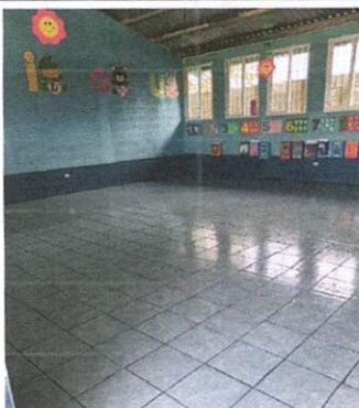
Foto 1: Sustitución de piso cerámico
