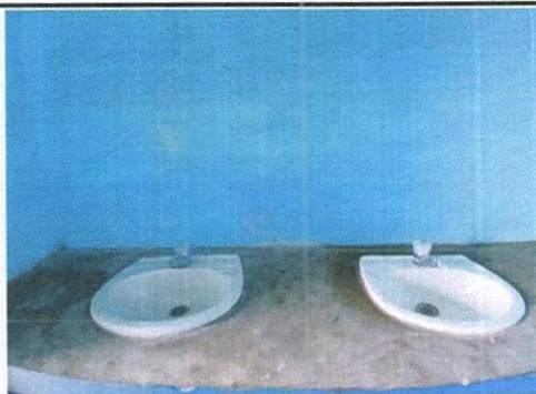
Foto 6: Sustitución de grifos
