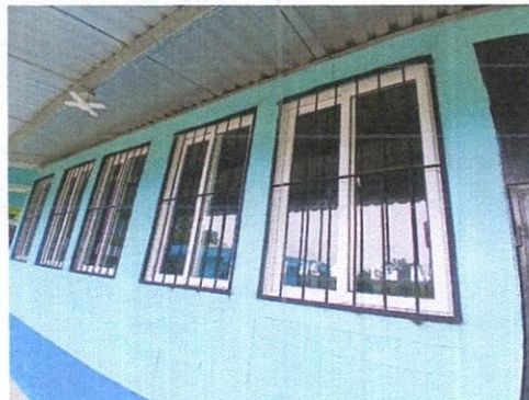
Foto 2: Fabricación e instalación de ventanas PVC
