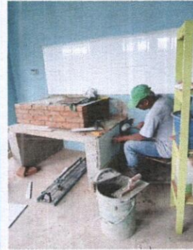
Foto 4: Sustitución de estufa rural (completa) incluye chimenea y plancha de metal
