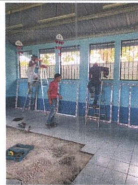
Foto 2: Fabricación e instalación de ventanas PVC
