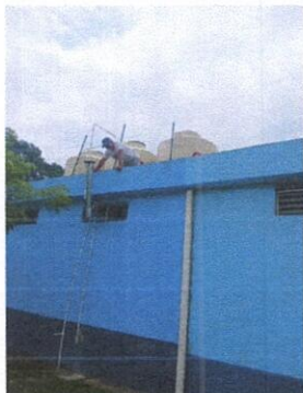
Foto 3: Sustitución de deposito de agua 1750 lt
