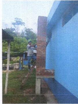
Foto 4: Sustitución de estufa rural (completa) incluye chimenea y plancha de metal
