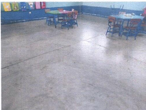
Foto 1: Sustitución de piso cerámico
