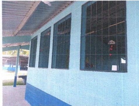
Foto 2: Fabricación e instalación de ventanas PVC
