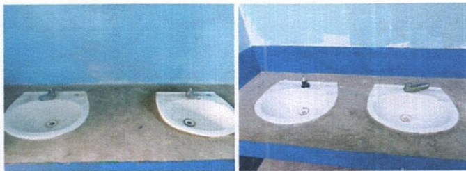
Foto 6: Sustitución de grifos
