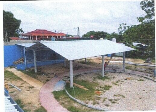
Foto 2: SUMINISTRO DE TECHO
