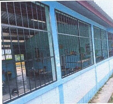
Foto 5: SUSTITUCION DE BALCONES DE METAL
