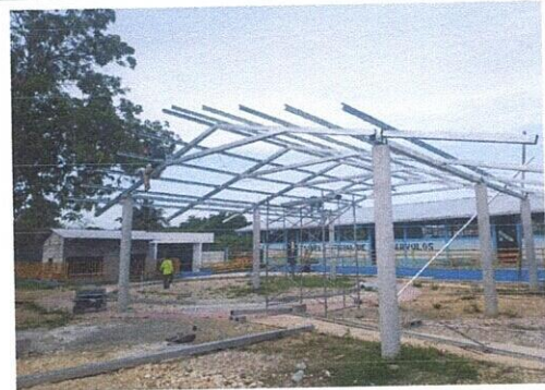
Foto 4: SUMINISTRO DE ESTRUCTURA PORTANTE
