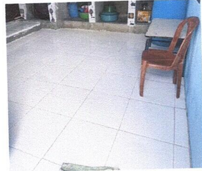
Foto 2: SUSTITUCION DE PISO CERAMICO
