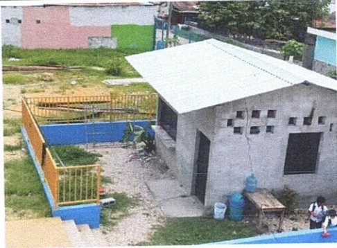
Foto1: SUMINISTRO DE TECHO EN COCINA
