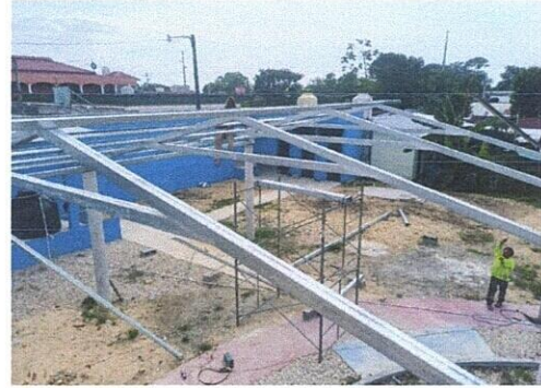
Foto 4: SUMINISTRO DE ESTRUCTURA PORTANTE
