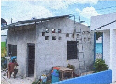
Foto1: SUMINISTRO DE TECHO EN COCINA
