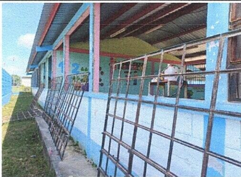
Foto 5: SUSTITUCION DE BALCONES DE METAL
