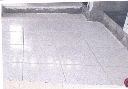
Foto 2: SUSTITUCION DE PISO CERAMICO
