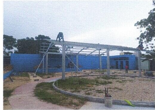
Foto 2: SUMINISTRO DE TECHO
