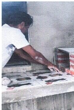
Foto 3: SUSTITUCION DE AZULEJO EN MUEBLES DE COCINA
