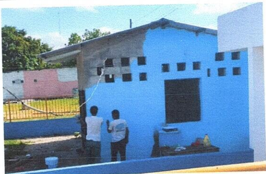
Foto 1: PINTURA EN MUROS INTERIORES Y EXTERIORES
