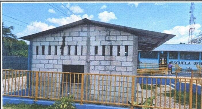
Foto 1: SUMINISTRO DE TECHO EN COCINA
