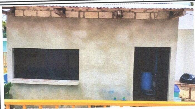
Foto1: PINTURA EN MUROS INTERIORES Y EXTERIORES
