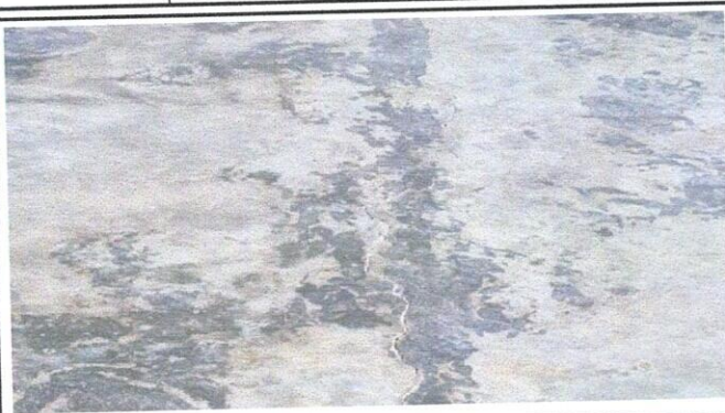
Foto 2: SUSTITUCION DE PISO CERAMICO
