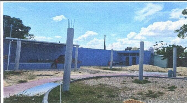
Foto 2: SUMINISTRO DE TECHO
