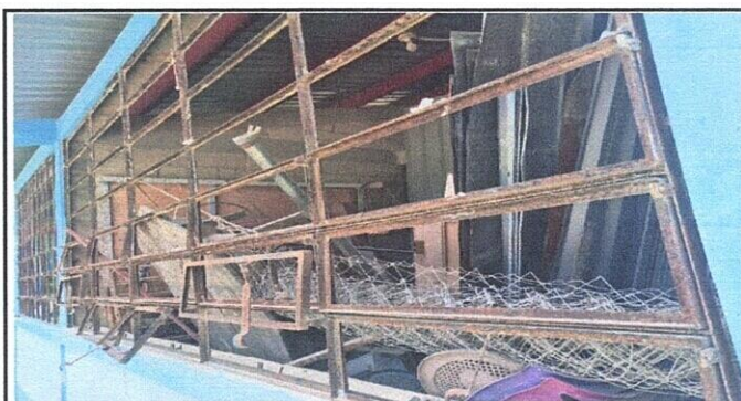
Foto 5: SUSTITUCION DE BALCONES DE METAL
