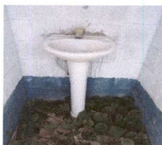
Foto 9: Sustitución de lavamanos
