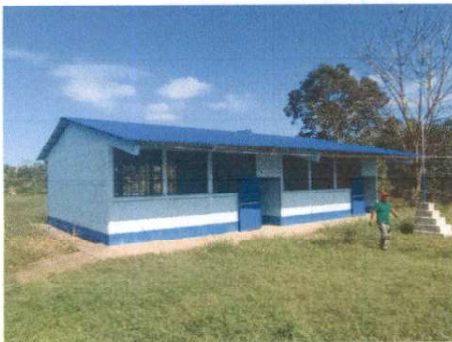
Foto 3: pintura en muros interior y exterior
