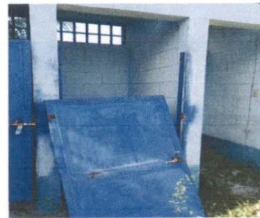
Foto 4: Sustitucion de puertas
