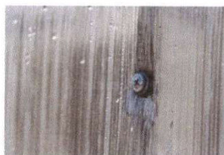
Foto 10: sustitucion de elementos de fijación
