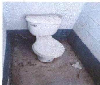
Foto 8: Sustitucion de inodoros
