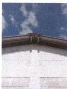
Foto 11: Sustitucion de capote de lámina para lámina troquelada
