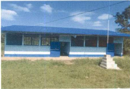
Foto1: Sustitución de lámina por lámina troquelada de aluzinc calibre 26
