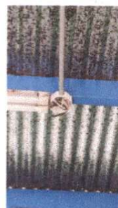
Foto 12: Reparación de cableado electrico
