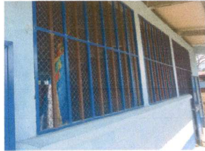
Foto 2: mantenimiento a balcones de metal
