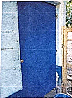
Foto 3.1: Fabricación e instalación de puertas de metal
