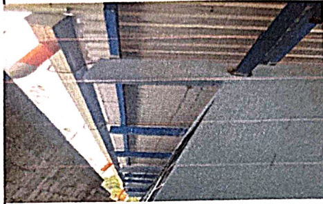
Foto 2.1: Sustitución de canal de metal
