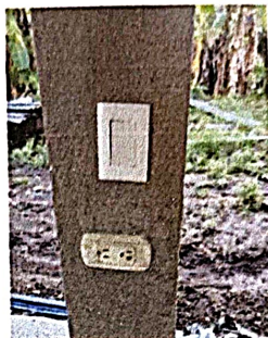
Foto 3.6: Instalación de unidades fuerza (tomacorriente), incluye cable eléctrico
