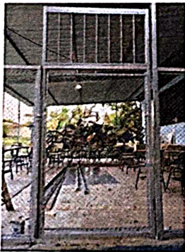
Foto 3.3: Fabricación e instalación de puerta de rejas
