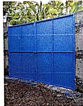
Foto 3.2: Fabricación e instalación de portón de metal de Salida
