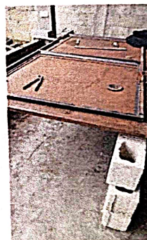
Foto 3.2: Fabricación e instalación de portón de metal de Salida
