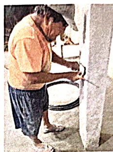
Foto 3.6: Instalación de unidades fuerza (tomacorriente), incluye cable eléctrico
