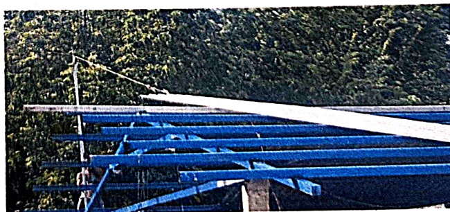
Foto 3.4: Instalación de estructura portante de metal más cubierta de lámina
