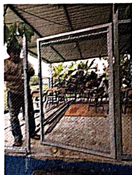
Foto 3.3: Fabricación e instalación de puerta de rejas
