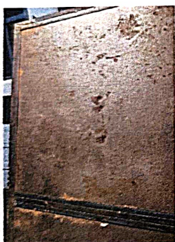
Foto 3.1: Fabricación e instalación de puertas de metal
