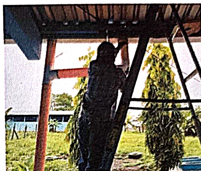
Foto 2.1: Sustitución de canal de metal
