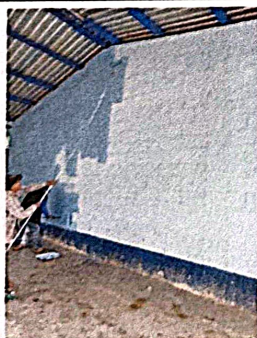
Foto 6.1: Pintura en muro exterior e interior
