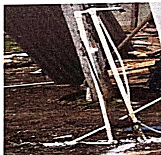
Foto 5. 1 : Sustitución de tubería línea principal
