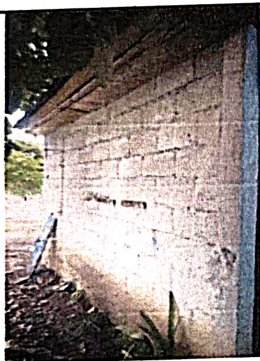
Foto 4.1: Repello en muro
