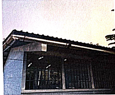
Foto 2.1: Sustitución de canal de metal
