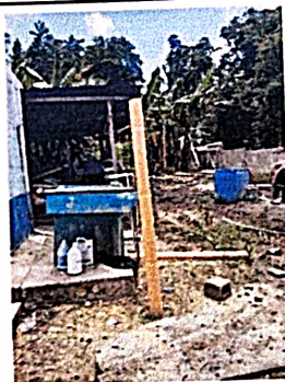
Foto 5.1: Sustitución de tubería línea principal
