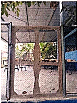
Foto 3.3: Fabricación e instalación de puerta de rejas
