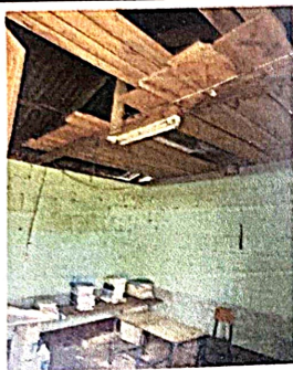
Foto 3.5: Instalación de unidades luz (incluye interruptor, ducto y cable eléctrico)
