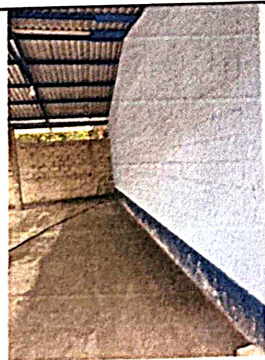
Foto 6.1: Pintura en muro exterior e interior
