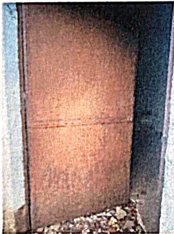
Foto 3.1: Fabricación e instalación de puertas de metal
