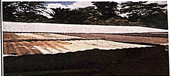
Foto 3.4: Instalación de estructura portante de metal más cubierta de lámina
