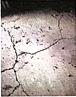
Foto 1.1: Reparación de piso de torta de concreto
