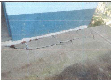
Foto 5: Reparación de piso de torta de concreto
