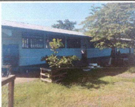
Foto 1: Sustrucción de lámina por lámina troquelada de aluzinc calibre 26
