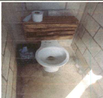
Foto 3: Sustrucción de inodoros
