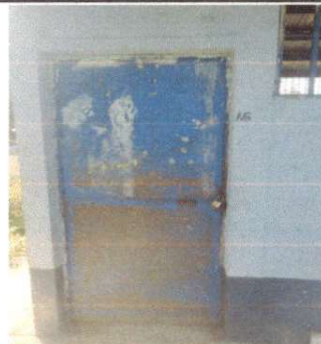
Foto 2: Mantenimiento a estructura de puertas de metal
