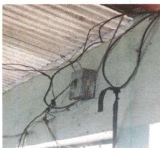
Foto7: Sustrución de ducto electrico mas accesorios
