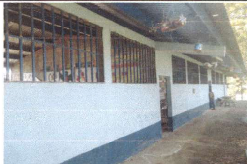
Foto 4: Pintura en muros interiores y exteriores
