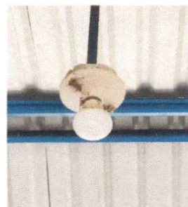
Foto 8: Sustrución de plafoneras
