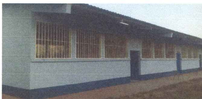
FOTO 5. PINTURA EN MUROS EXTERIORES E INTERIORES
