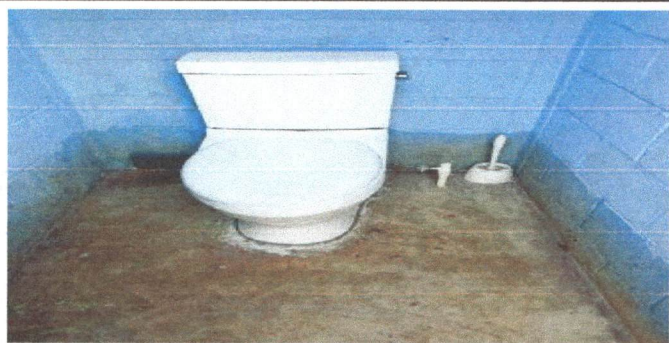
FOTO 3 SUSTITUCION DE INODOROS
