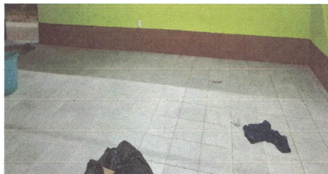
FOTO 2 MEJORAMIENTO DE PISO DE CEMENTO LIQUIDO POR CERAMICA
