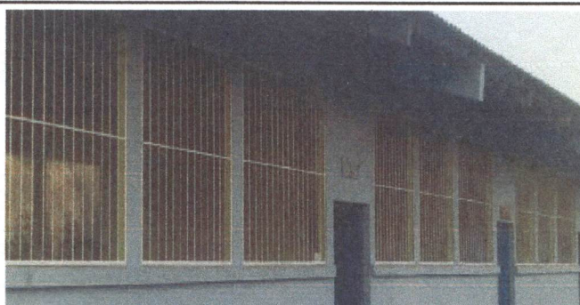
FOTO 6. MANTENIMIENTO A BALCONES DE METAL
