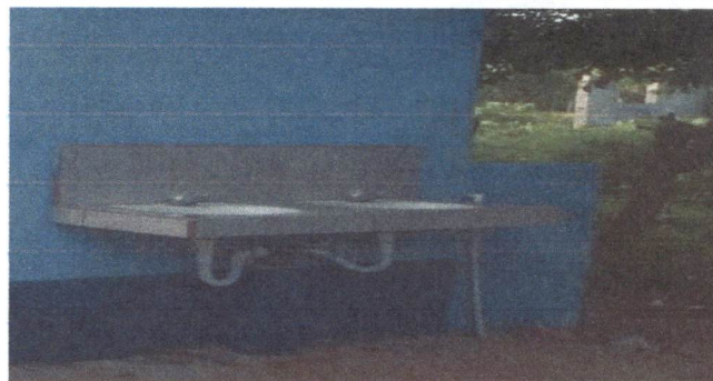
FOTO 4. SUSTITUCION DE LAVAMANOS
