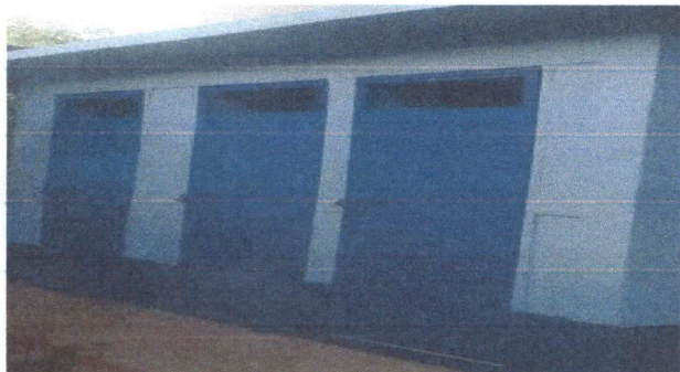
FOTO 1. MANTENIMIENTO A PUERTAS
