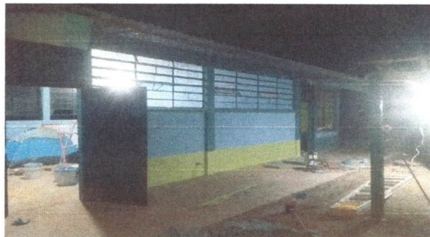
FOTO 1. SUSTITUCION DE PUERTAS
