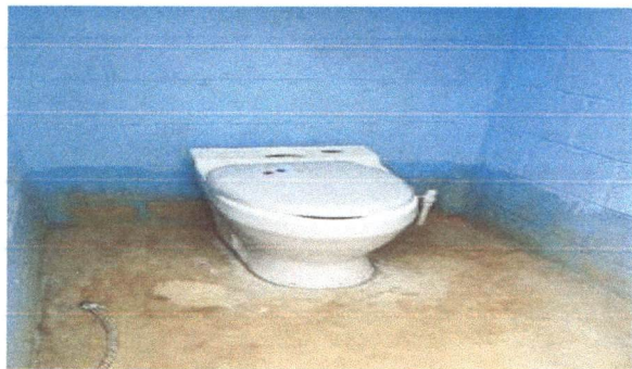
FOTO 3 SUSTITUCION DE INODORO
