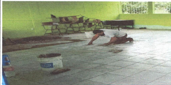
FOTO 2. SISTITUCION DE PISO DE CEMENTO LIQUIDO
