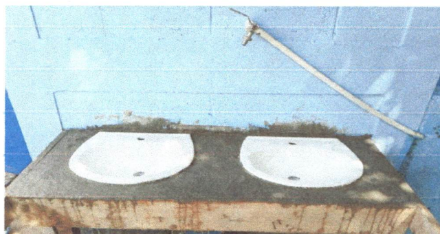
FOTO 4. SUSTITUCION DE LAVAMANOS
