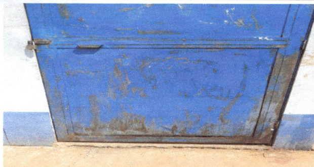
FOTO 1. SUSTITUCION DE PUERTAS
