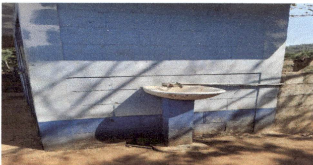
FOTO 4. SUSTITUCION DE LAVAMANOS
