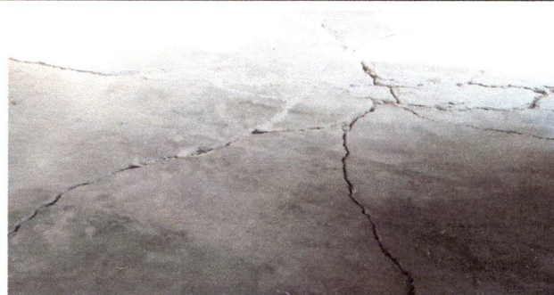
FOTO 2. SISTITUCION DE PISO DE CEMENTO LIQUIDO
