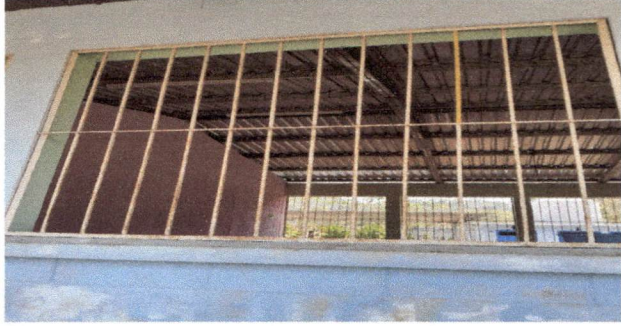
FOTO 6. MANTENIMIENTO A BALCONES DE METAL
