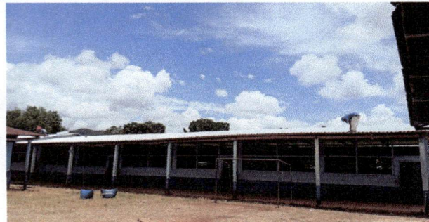
Foto 2: Sustitución de lámina, por lámina troquelada de aluzinc calibre 26
