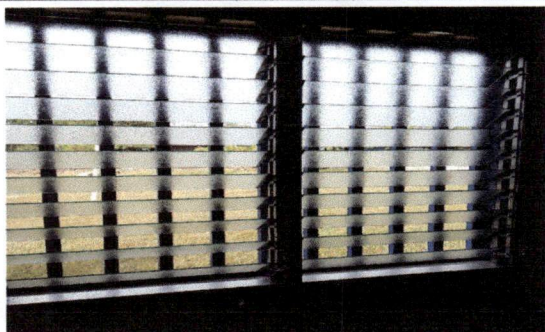
Foto 3 : Sustitución de ventana de madera por metal mas vidrio
