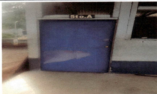
Foto1: Sustitución de puertas
