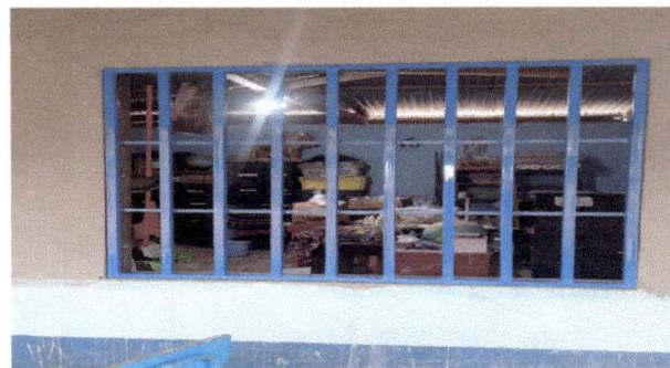
Foto 4: Sustitución de balcon de metal
