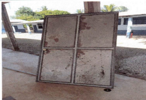
Foto1: Sustrucción de puertas
