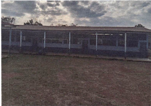
Foto 2: Sustitución de lámina, por lámina troquelada de aluzinc calibre 26
