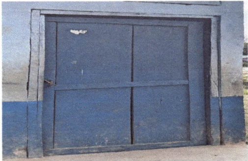
Foto1: Sustitución de puertas
