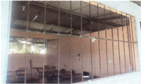
Foto 4: Sustitución de balcon de metal
