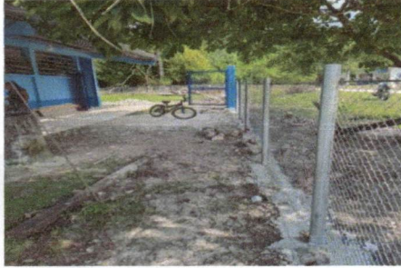
Foto 1: Reparación de tubo hg y malla galvanizada con fundición del tubo y maya en el cimient
