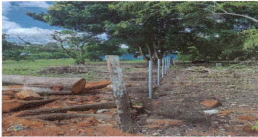
Foto 1: Reparación de tubo hg y malla galvanizada con fundición del tubo y maya en el cimiento
