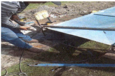
Foto 3: Mantenimiento a estructura (lijado, cambio de tubo, cepillado, sujeciones, aplicación de pintura)
