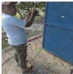
Foto 5: Reparación de sistema eléctrico: sustitución de lámparas, plafoneras, interruptores, tomacorrientes, sustitución de ducto eléctrico y reparación de cable eléctrico
