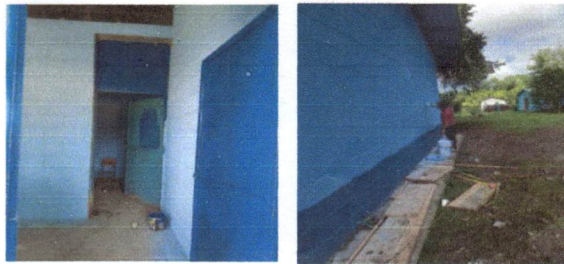
Foto 4: Pintura en muros exteriores e interiores
