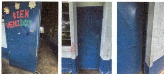
Foto 3: Mantenimiento a estructura (lijado, cambio de tubo, cepillado, sujeciones, aplicación de pintura)
