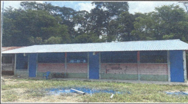
Foto 1: CAMBIO TOTAL DE LA ESCUELA CASI COMPLETA.
