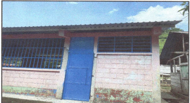
Foto 4: CAMBIO DE PUERTAS NUEVAS EN DOS AULAS, DIRECCION Y BODEGA.
