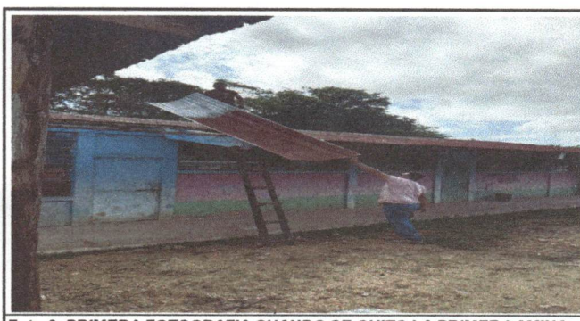
Foto 6: PRIMERA FOTOGRAFIA CUANDO SE QUITO LA PRIMER LAMINA DEL TECHO.
