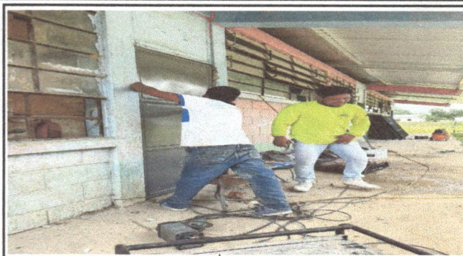
Foto 2: COLOCANDO LA PUERTA NUEVA Y DANDOLE SU BUENA PINTURA.
