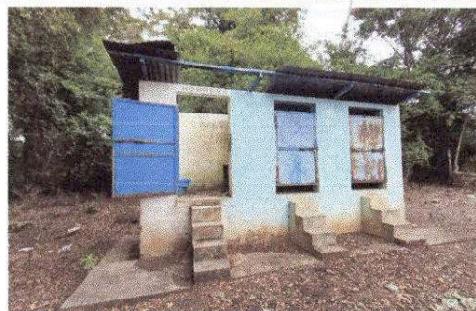
Foto 2: Sustrucción de lamina por lámina troquelada de aluzinc calibre 26
