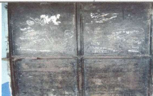
Foto 2: Mantenimiento a estructura de puertas
