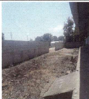
Foto 3: Pintura en muros exteriores e interiores.
