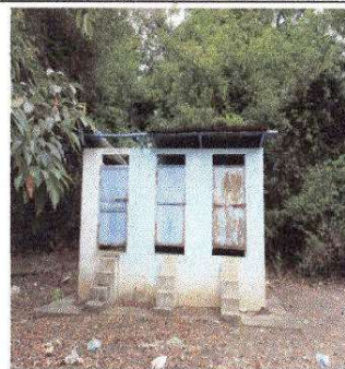
Foto 3: Pintura en muros exteriores e interiores.
