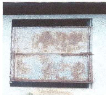
Foto 4: Sustitución de puertas en servicios sanitarios
