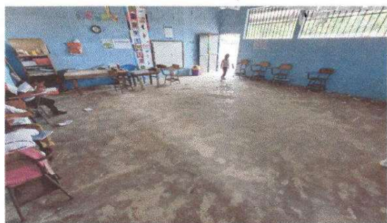
Foto1: Reparación de piso de cemento liquido
