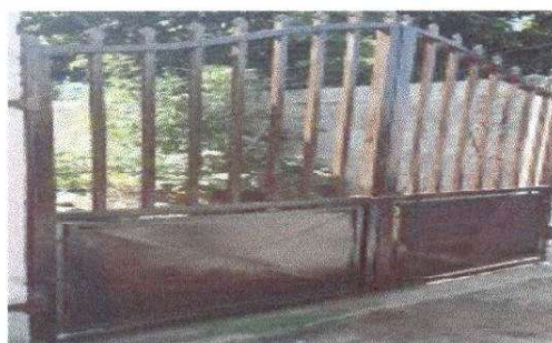
Foto 6: Fabricación e instalación de porton de metal de ingreso.
