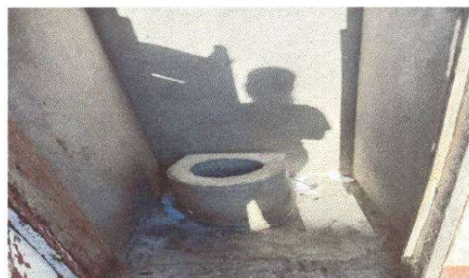
Foto 5: Instalación de letrina de cemento
