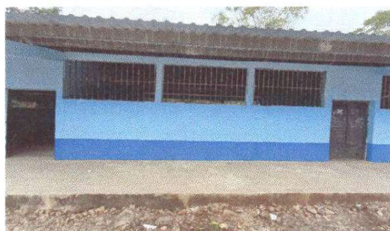
Foto 3: Mantenimiento a balcones de metal
