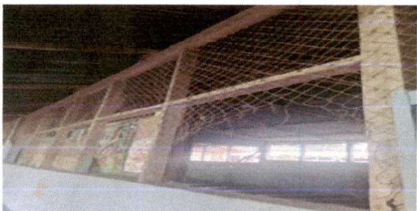
Sustitución de balcones de metal
