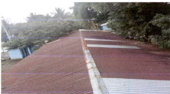
Sustitución de lámina, por lamina troquelada aluzinc calibre 26
