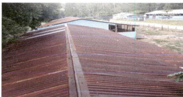
Sustitución de elementos de fijación
