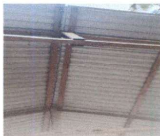
Foto1: sustitución de lámina, por lámina troquelada aluzinc calibre 26; cocina
