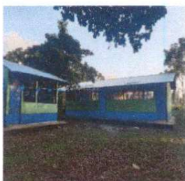
Foto 3: pintura en muro exteriores e interiores; aulas.
