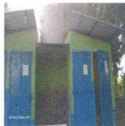
Foto 4: pintura en muro de interiores y exteriores; baños.
