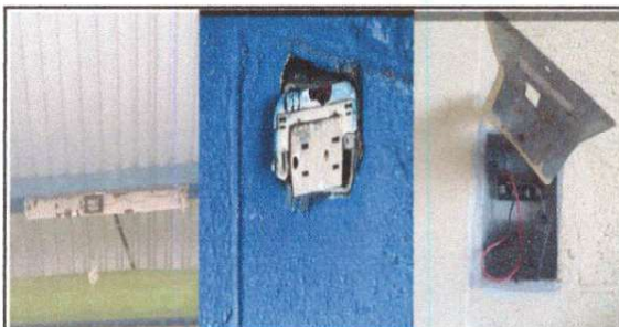
sustitución de ducto eléctrico mas accesorios
