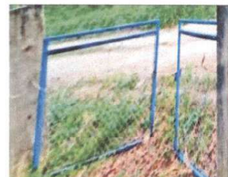
Foto 6: sustitución de portón de metal
