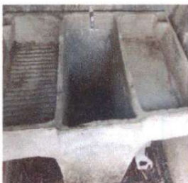
Foto 1: sustitución de pila de cemento de dos lavaderos; cocina
