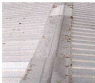
Foto 2: sustitución de capote de lamina para lámina troquelada; cocina
