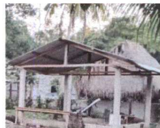
Foto 3: sustitución de estructura de soporte de madera por metal; cocina
