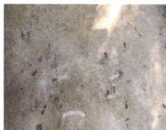
Foto 4: sustitución de piso de cemento líquido; cocina
