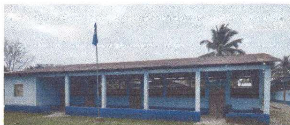
Foto 10: Pintura en muros interiores y exteriores
