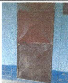
Foto 5: Fabricación e instalación de puerta en módulos
