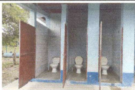
Foto 11: Sustitución de inodoros
