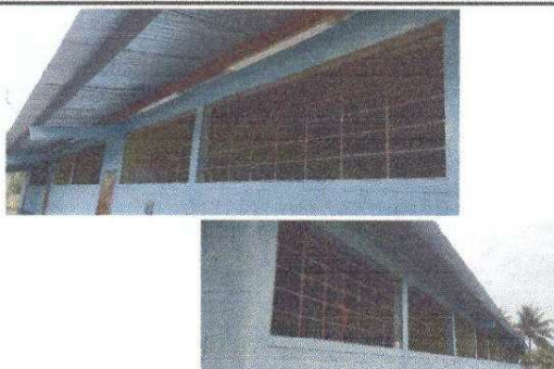
Foto 7: Mantenimiento a balcones de metal
