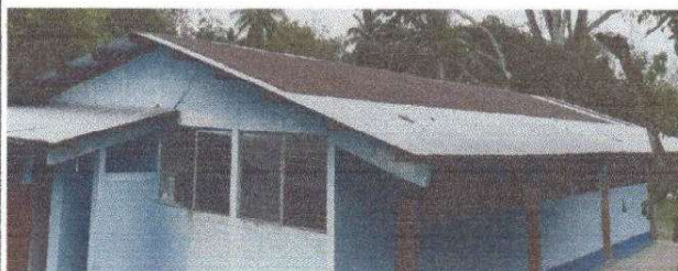
Foto 2:Sustitución de capote de lámina para lámina troquelada
