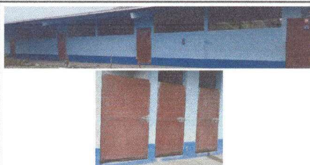
Foto 6: Mantenimiento a estructura de puertas de metal
