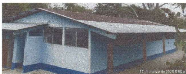
Foto 3: Sustitución de elementos de fijación
