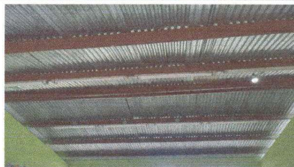
Foto 4: Mantenimiento a estructura de soporte de metal
