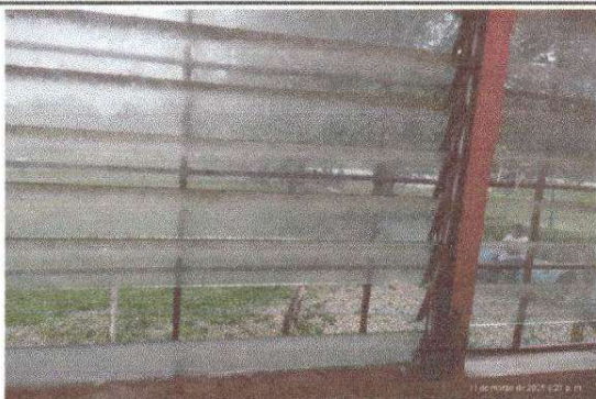
Foto 9: Fabricación e instalación de ventana
