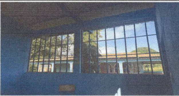
Foto 3: Mantenimiento a balcones de metal
