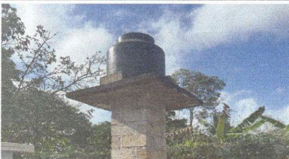
Foto 5: Sustitución de depósito de agua 1100 lt
