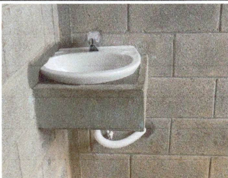
Foto7: Sustitucion de lavamanos
