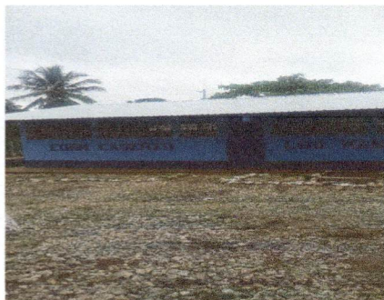
Foto1: Sustitucion de lamina
