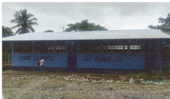
Foto 5: Pintura en muros
