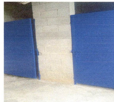
Foto 2: sustitucion de puertas
