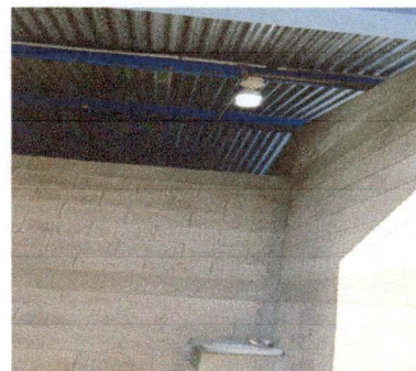
Foto 8: sustitucion de focos ahorradores y plafoneras
