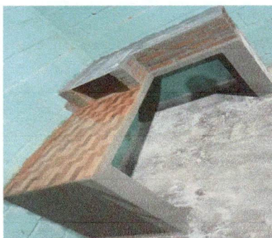
Foto 9: Sustitucion de estufa rural
