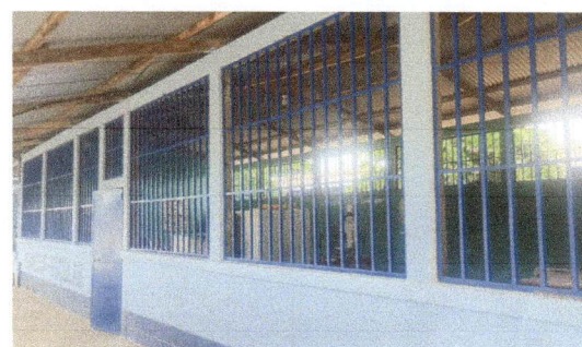
Foto 4: Sustitucion de balcones de metal
