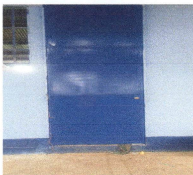
Foto 3: Mantenimiento a estructura de puertas
