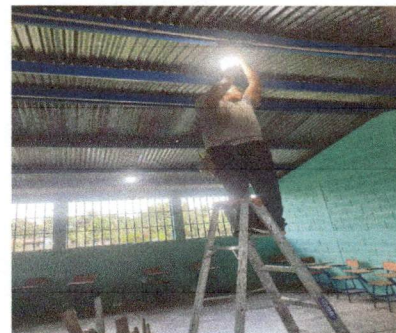
Foto 8: sustitucion de focos ahorradores y plafoneras
