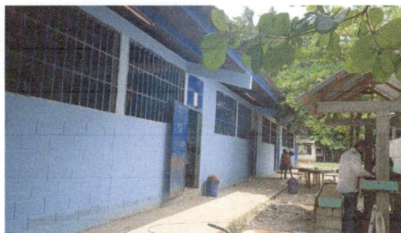
Foto 5: Pintura en muros
