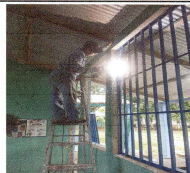
Foto 4: Sustitucion de balcones de metal
