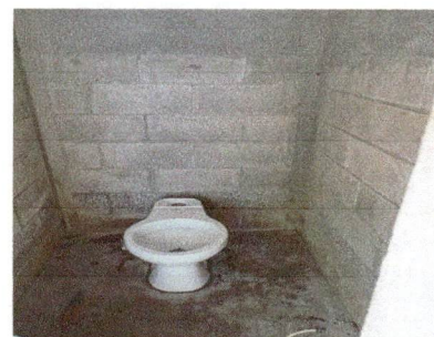
Foto 6: Sustitución de inodoro
