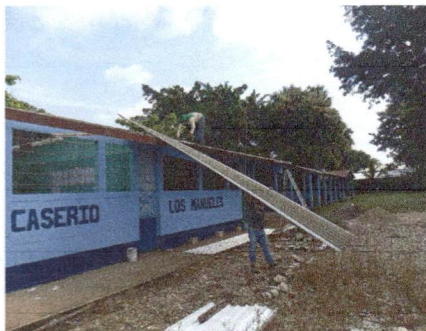
Foto1: Sustitucion de lamina
