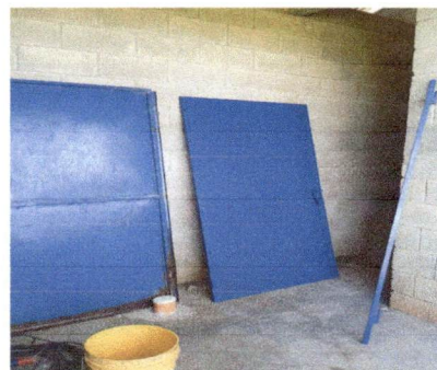
Foto 2: sustitucion de puertas
