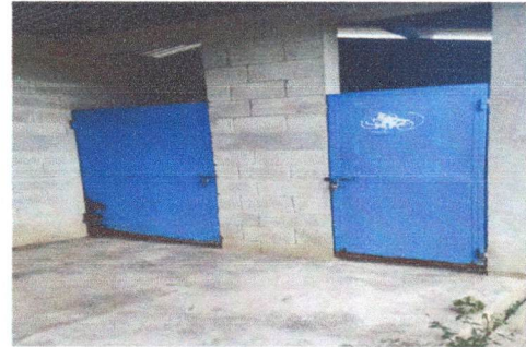
Foto 2: sustitución de puertas
