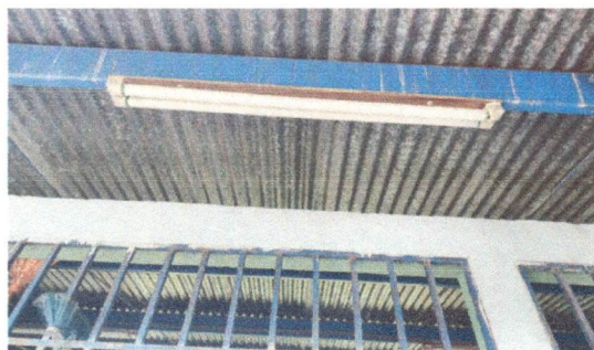
Foto 8: sustitucion de focos ahorradores y plafoneras
