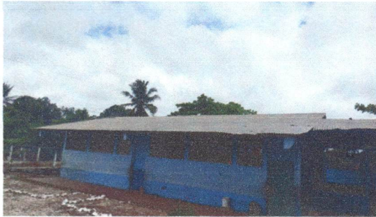
Foto1: Sustitución de lámina
