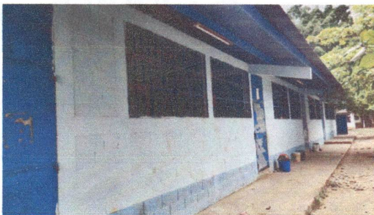
Foto 5: Pintura en muros
