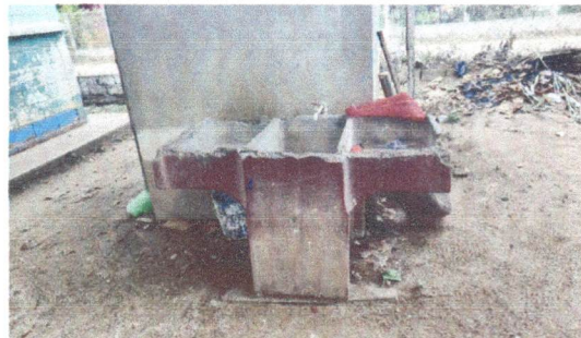
Foto 10: Sustitucion de pila de cemento de 2 lavaderos
