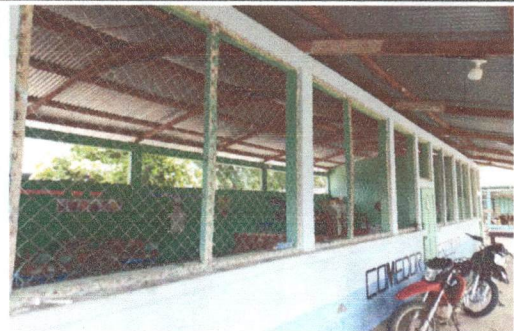
Foto 4: Sustitución de balcones de metal
